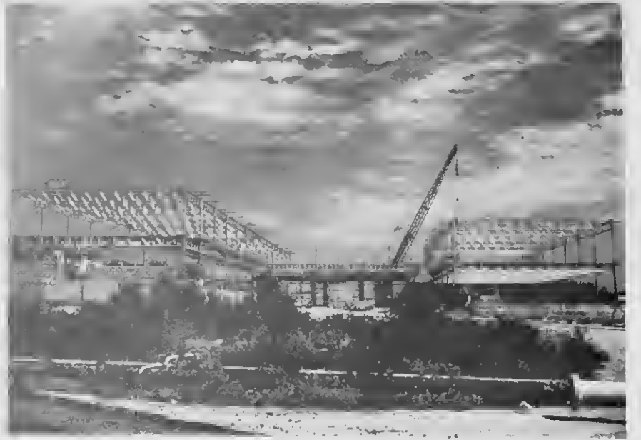
NEARLY COMPLETED, the building's bones sparkle in the Caribbean sun. CERCA CLA, wesonan di e edificio ta brilla den solo di Caribe.
